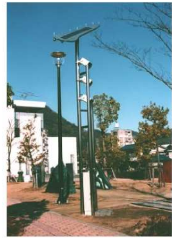
ソーラー音響装置 (メロディーズ) 特長 太陽光を電気に変え人が 近づくとメロディーが流れます。
